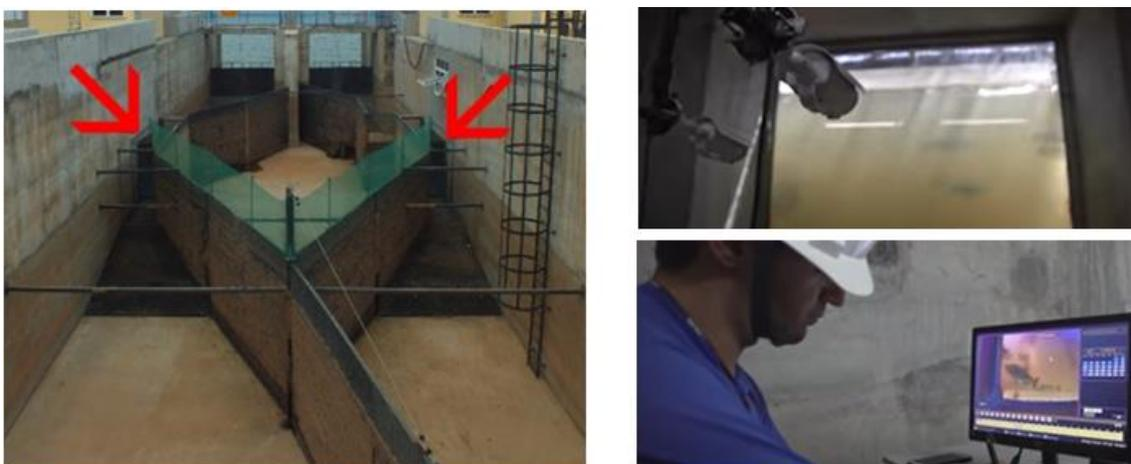
**Figura 3.** À esquerda, porção final do STP (montante) quando seco, com detalhe para os visores da sala direita e esquerda, indicados pelas setas vermelhas. À direita, o sistema de câmeras na figura de cima e, abaixo, a análise de imagens gravadas pelo Sistema Vídeo-Imagem (SVI). Fonte: Norte Energia, 2023.
