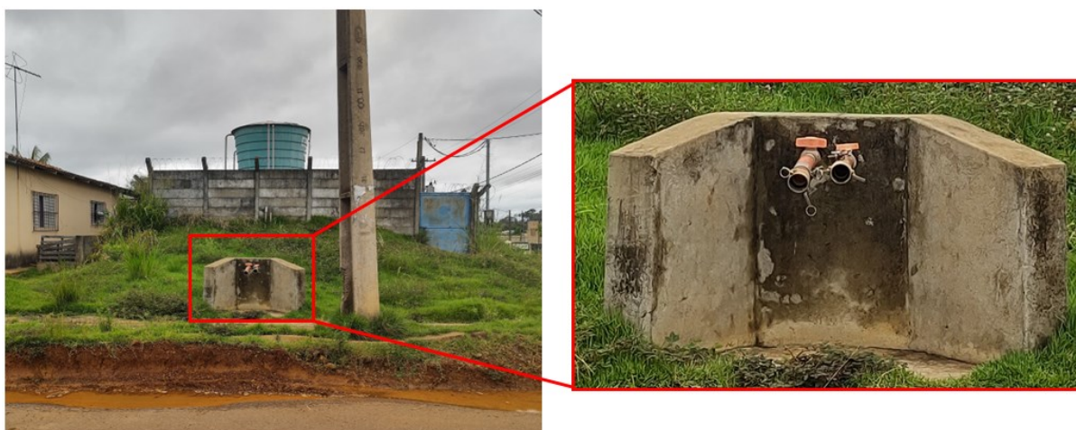
Figura 2 - Reservatórios de distribuição de água no RUC Água Azul.
